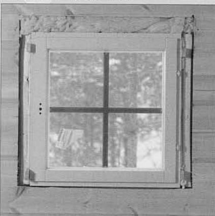
Рис.8 Крепление окна к деревянному гребню.
