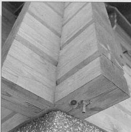
Рис.5 Сквозное соединение в шип.
